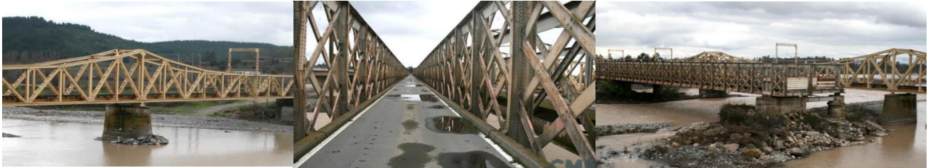
Imagen 2: Puente Carretero y Ferroviario - Río Maule
